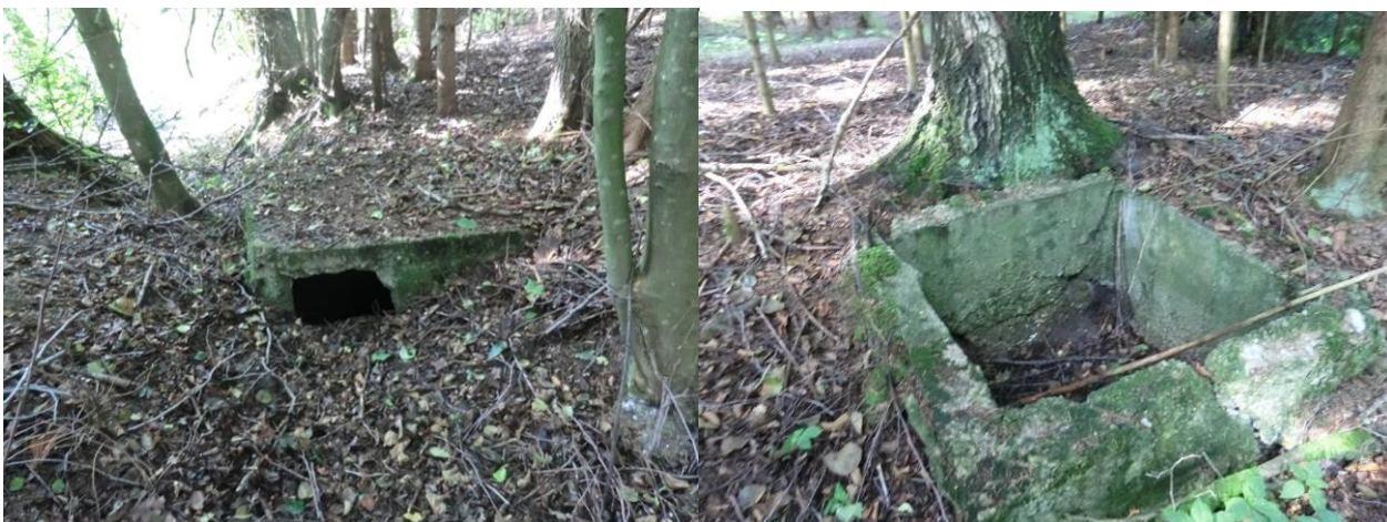
Abbildung 18: Alte Sickerschächte
